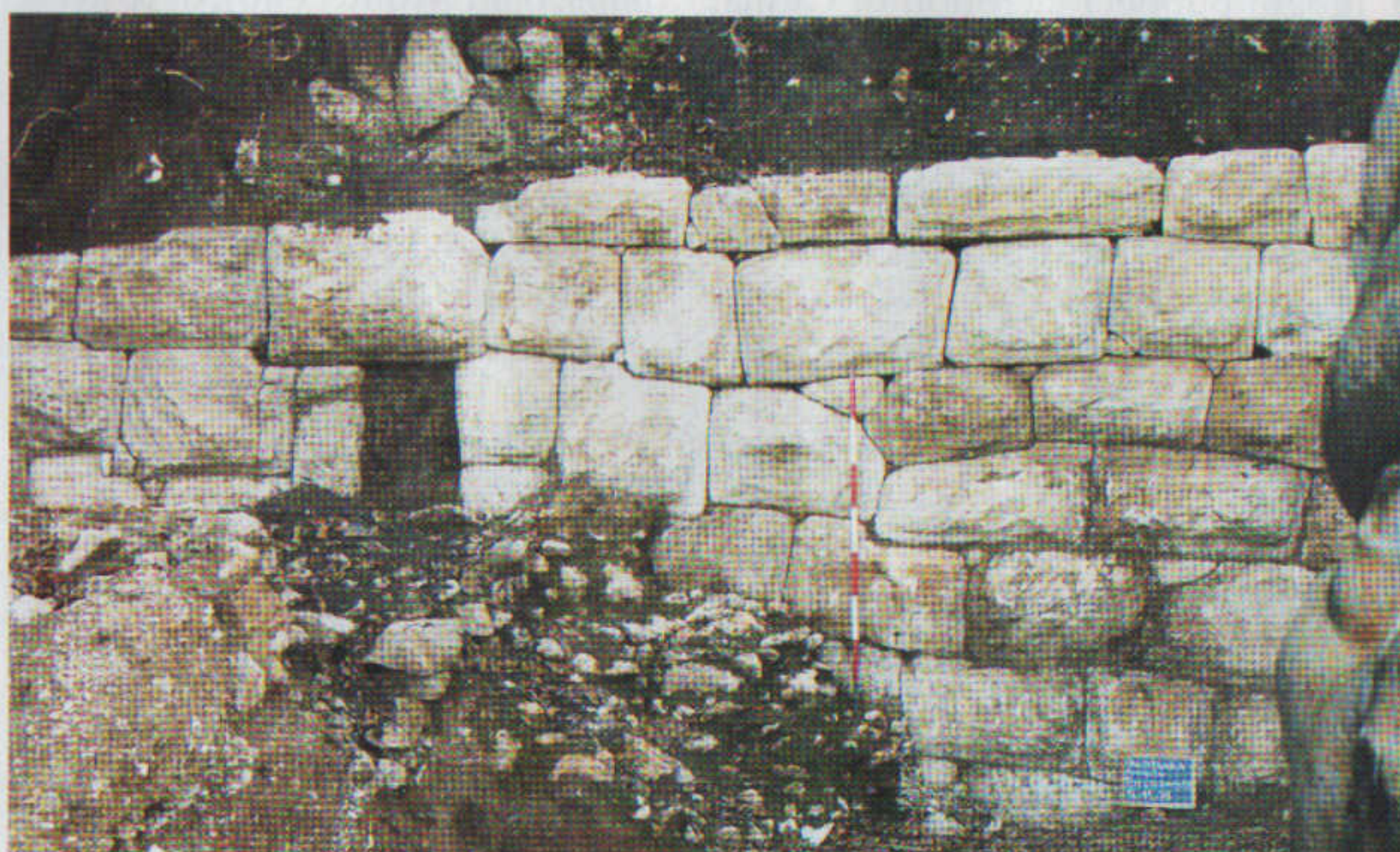
Particolare del terrazzamento della villa, realizzato in opera poligonale.
