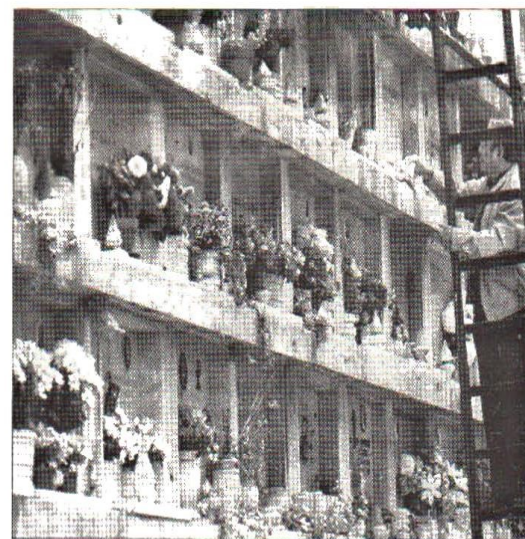
Partono i lavori di recupero dell'ala vecchia del cimitero
