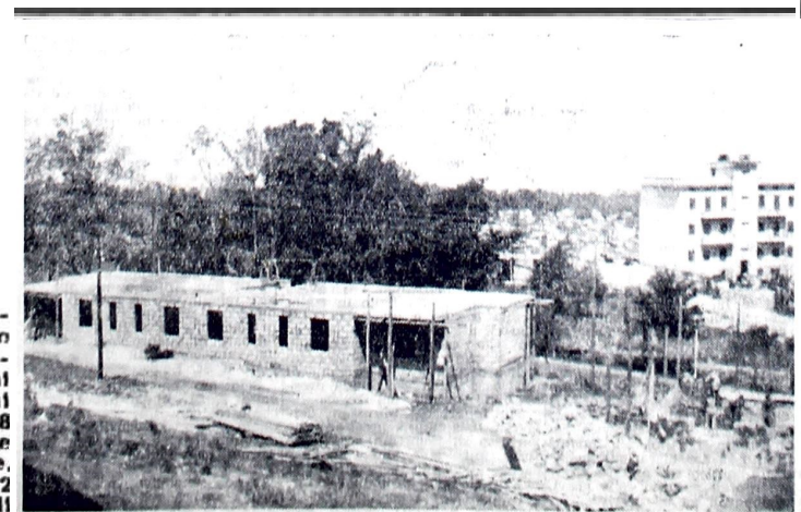
PALOMBARA. — Una visione dei lavori in corso per le nuove case I.N.A.I.L.
