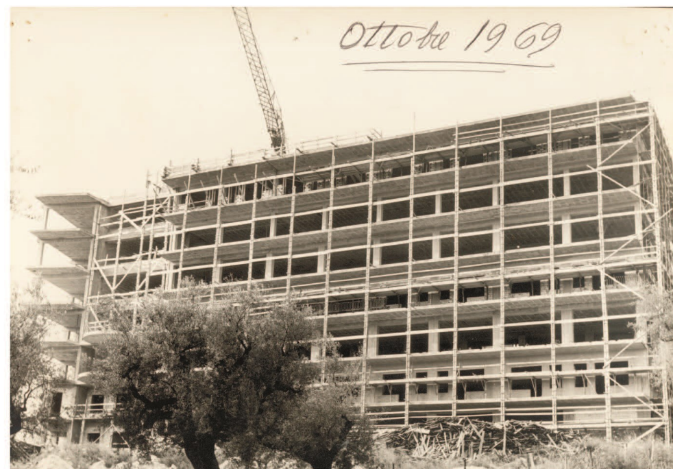
La struttura in cemento armato del nuovo ospedale - Ottobre 1969
